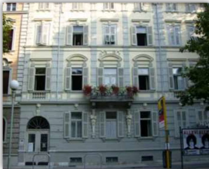
La facciata esterna e, a sinistra, il portone d'ingresso dell'edificio
